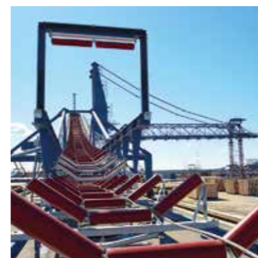
Монтаж конвейерных линий на территории АО «Балтийский балкерный терминал»
