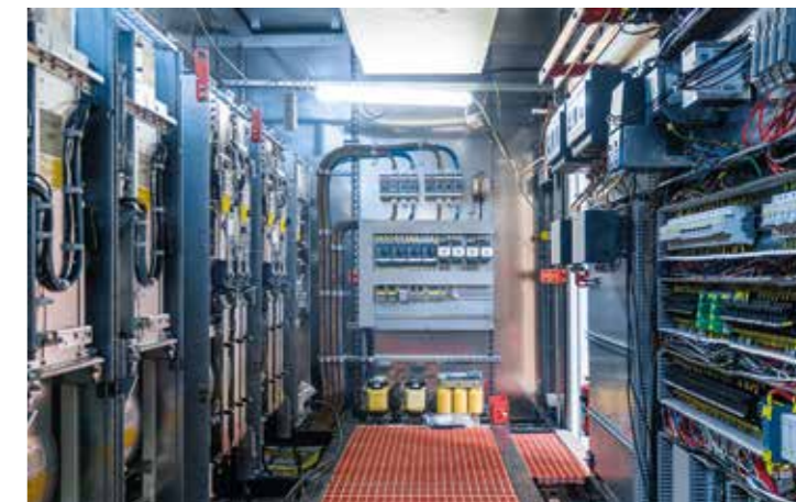
Процесс сборки электропомещения портального крана
