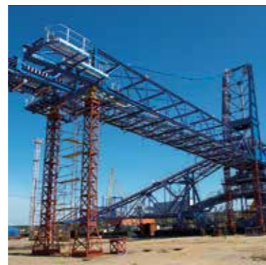
Монтаж оборудования на терминале «Ростерминалуголь» в порту Усть-Луга
