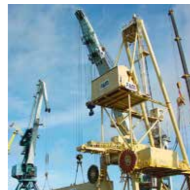
Монтажные работы на территории АО «Балтийский балкерный терминал»
